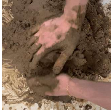
RUČNÍ MÍCHÁNÍ A ODSTRAŇOVÁNÍ VZDUCHOVÝCH BUBLIN
